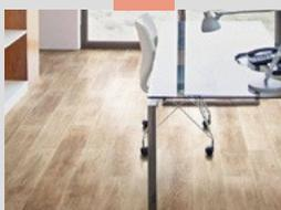
PAVIMENTO DE VINIL FLUTUANTE DA MARCA WICANDERS OU EQUIVALENTE. APLICADO EM TODA A MORADIA, À EXCEÇÃO DA GARAGEM E INSTALAÇÕES SANITÁRIAS.
